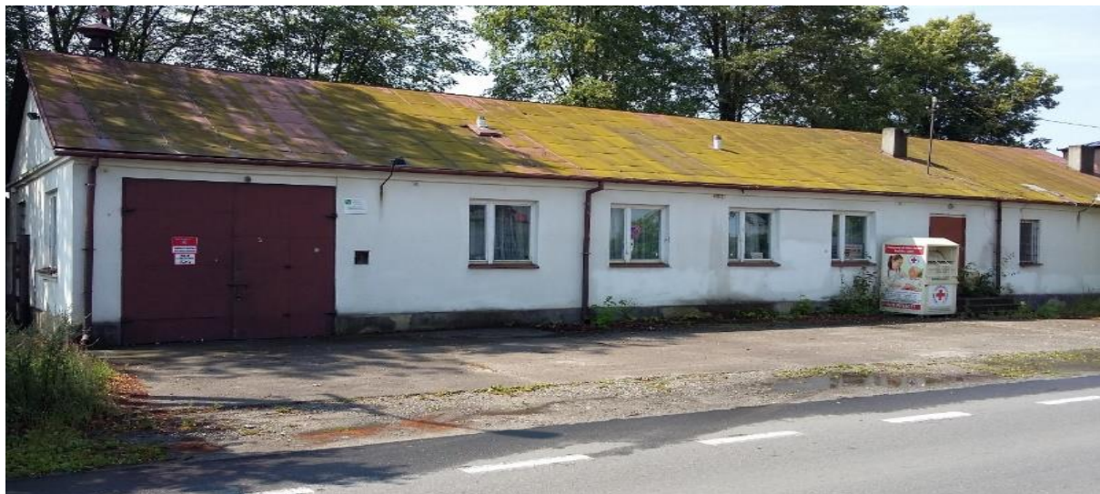
Fotografia 5. Świetlica wiejska w Nowodworze – stan przed realizacją projektu (widok z ulicy)
