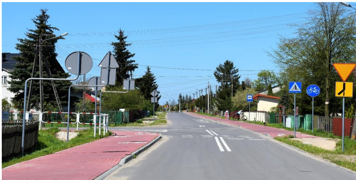
Fotografia 16. Rozbudowa drogi gminnej nr 103366L Szczekarków - Brzeziny oraz drogi gminnej Nr 103368L w miejscowości Brzeziny
