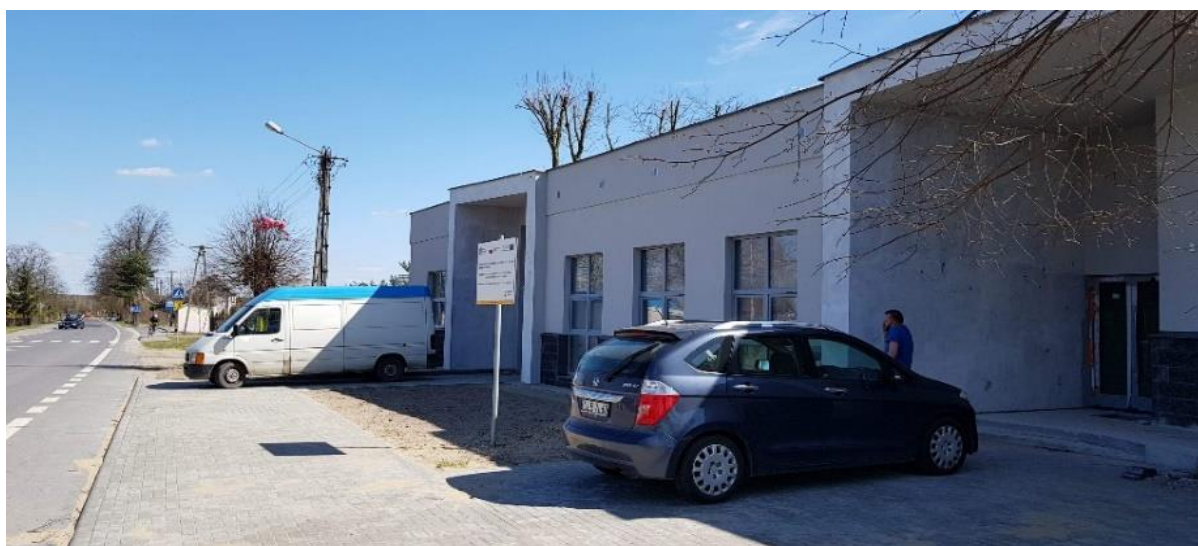
Fotografia 8. Wiejski Dom Kultury w Nowodworze - stan po realizacji projektu (front budynku)
