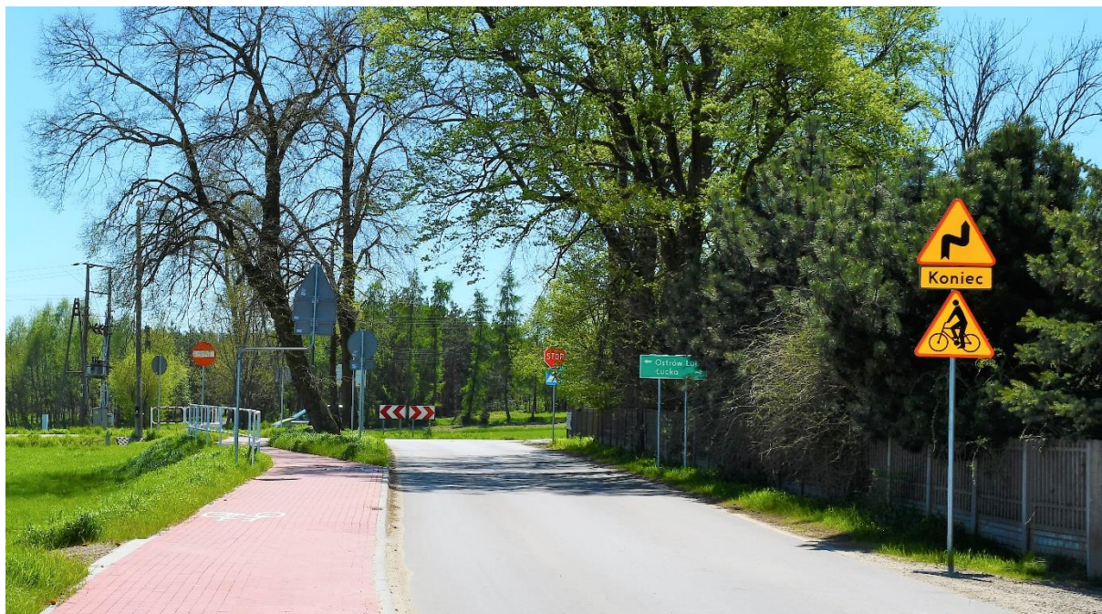
Fotografia 12. Rozbudowa drogi gminnej nr 103363L Łucka – Lubartów
