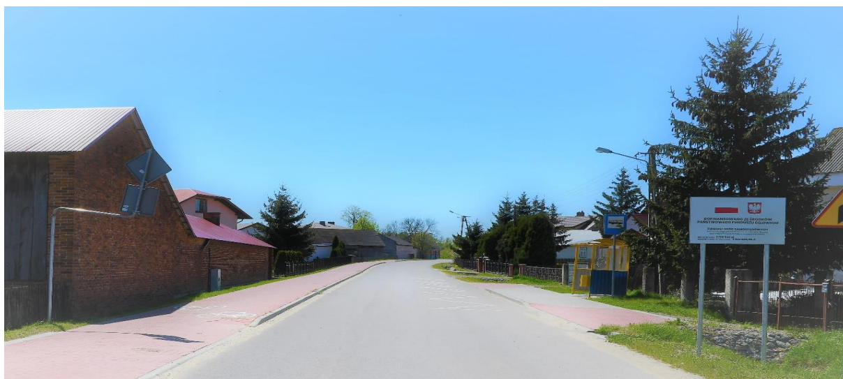
Fotografia 15. Rozbudowa drogi gminnej nr 103366L Szczekarków - Brzeziny oraz drogi gminnej Nr 103368L w miejscowości Brzeziny
