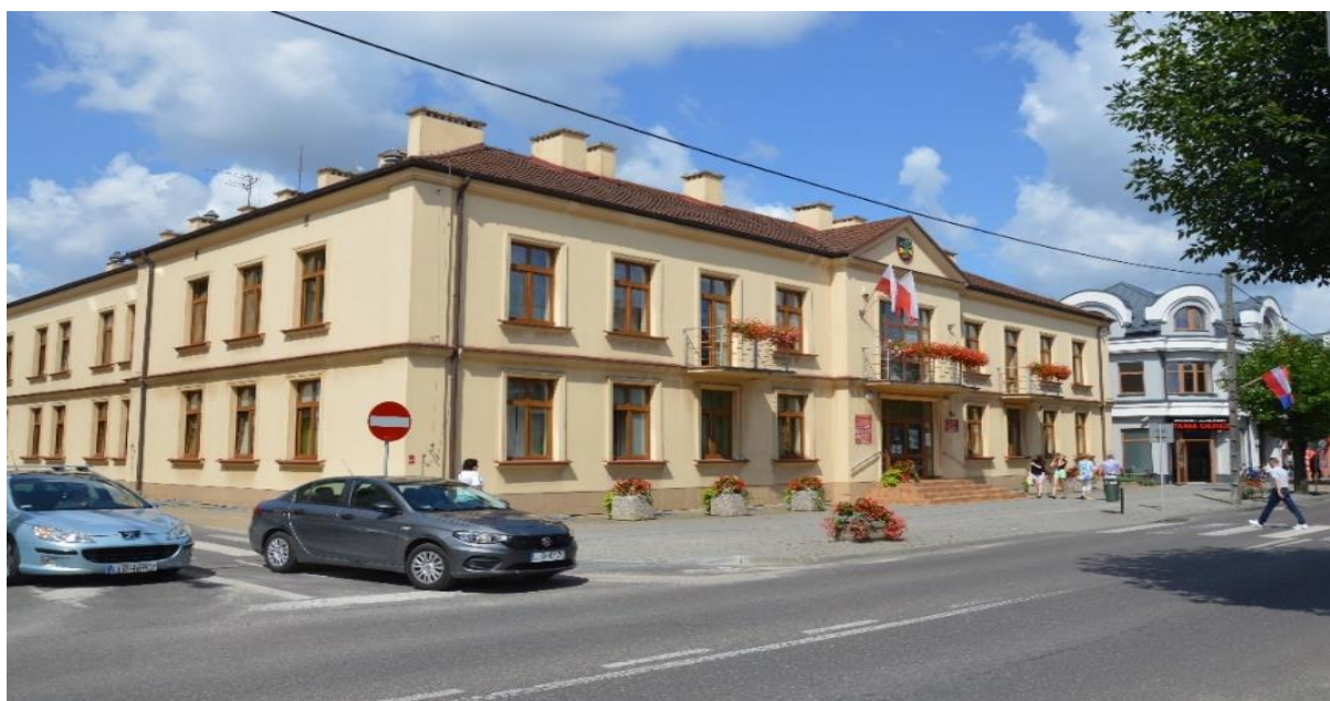
Fotografia 1. Budynek Urzędu Gminy Lubartów
