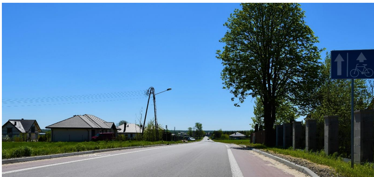
Fotografia 11. Rozbudowa drogi gminnej nr 103350L Nowodwór – Skrobów-Kolonia
