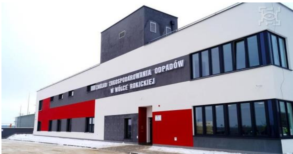
Fotografia 24. Zakład Zagospodarowania Odpadów w Wólce Rokickiej
