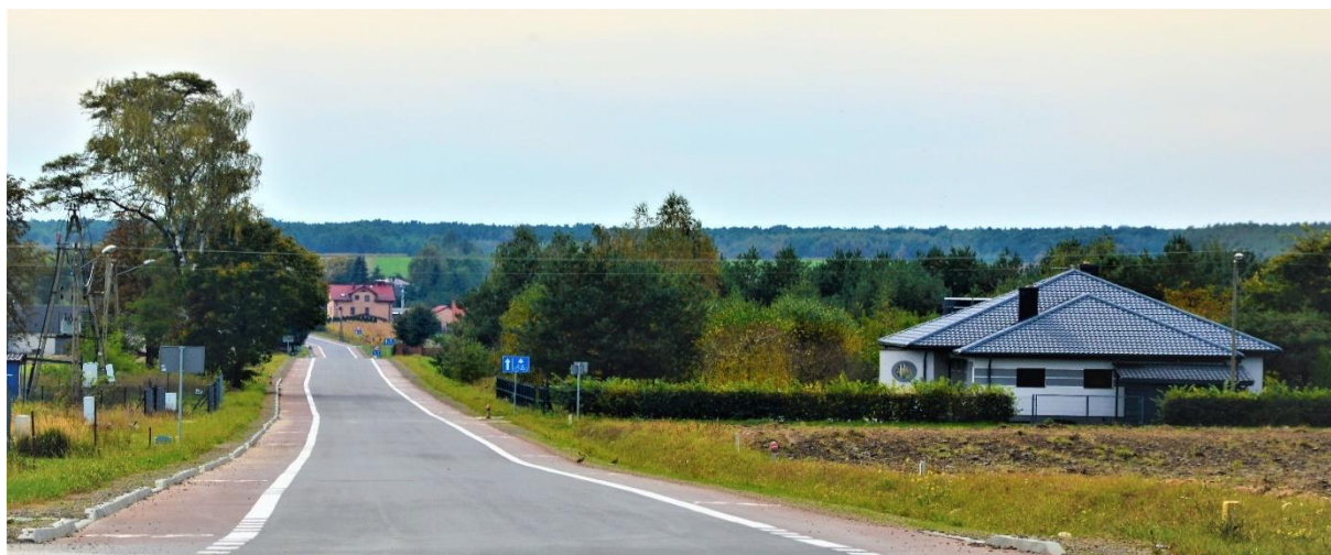
Fotografia 10. Rozbudowa drogi gminnej nr 103350L Nowodwór – Skrobów-Kolonia
